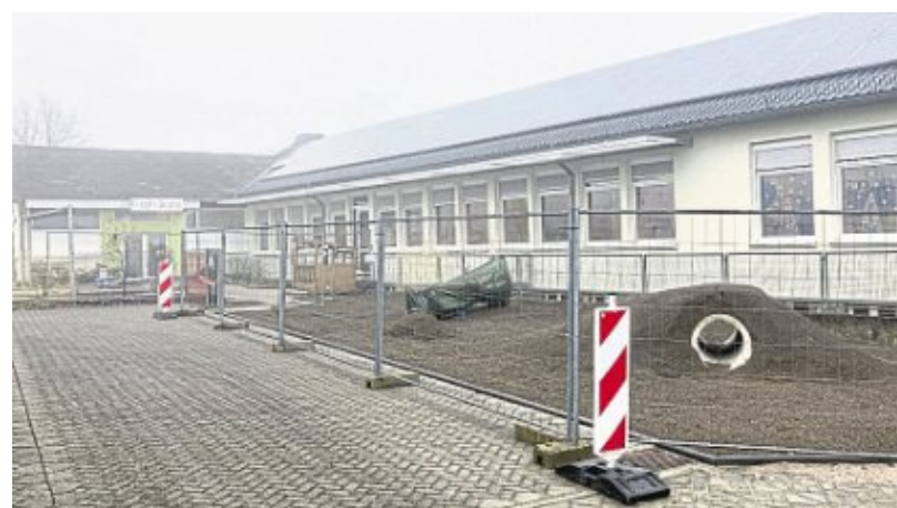
Der Außenbereich der Kita wurde bereits erweitert. Bis die Kinder dort spielen können, müssen noch ein paar Arbeiten erledigt werden.
